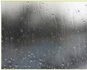
Der Feind im Haus: Feuchtigkeit
