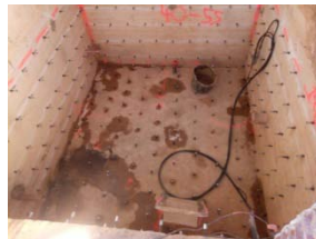
BU: Für die Verschleierung wird ein Bohrschema in einem Fahrstuhlschacht im Hauptgebäude des Klosters gelegt. (Foto: Getifix GmbH)
