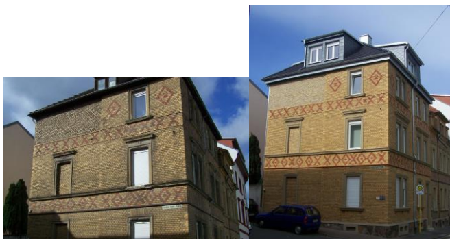
BU: Das über 100 Jahre alte Backsteinhaus in Bingen wurde von innen komplett gedämmt und erstrahlt heute auch außen im neuen Glanz.
