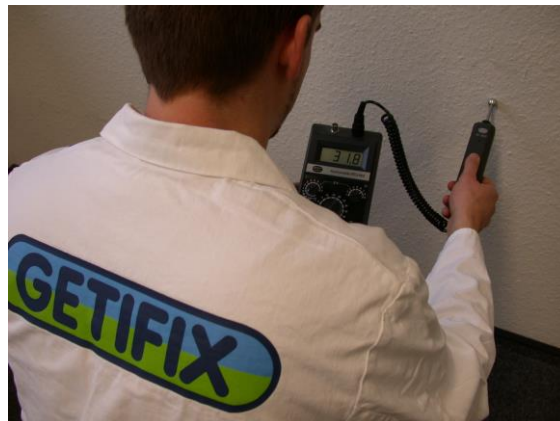
BU: Zu einer gründlichen Analyse des Raumklimas gehört auch eine Messung der Feuchtigkeit im Mauerwerk.
