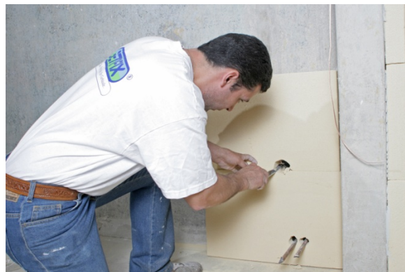
BU: Der Getifix Fachmann erstellt Rohrdurchführungen, z.B. mit einem Messer.
