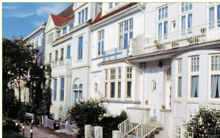
■ Jedes dritte Gebäude in Deutschland hat mit Schimmelpilz zu kämpfen
